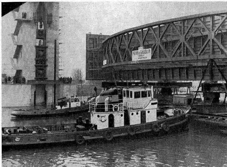
De schuif wordt ingevaren
