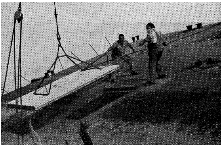
Het aanbrengen van de luiken op het dek
