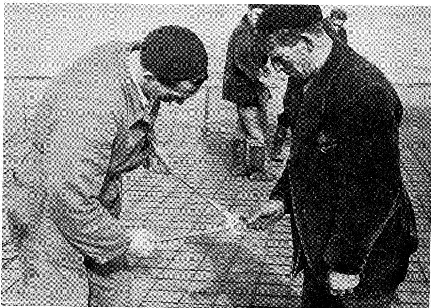
2. Aanbrengen van de schalmen
