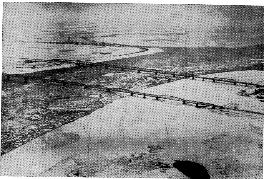
Ijsafvoer bij de Moerdijkbruggen
