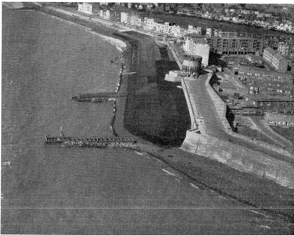
De „Boulevard de Ruyter” te Vlissingen na het aanbrengen van de verzwaring voor het westelijke gedeelte van de zeemuur. Rechtsonder een gedeelte van de oude zeewering zonder buitenberm 3-10-'58
