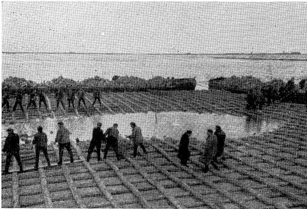
Een rietplaten zinkstuk tijdens het ballasten
