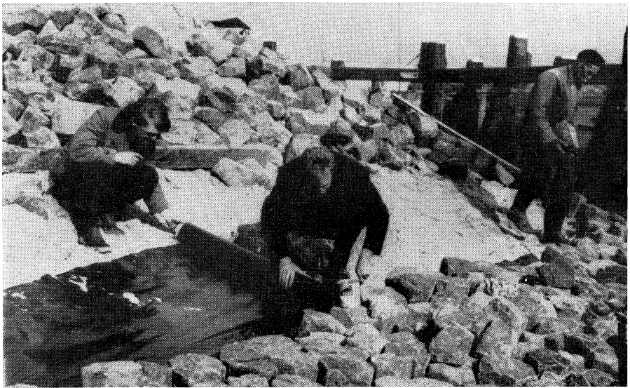
Het aanbrengen van de plastic folie
