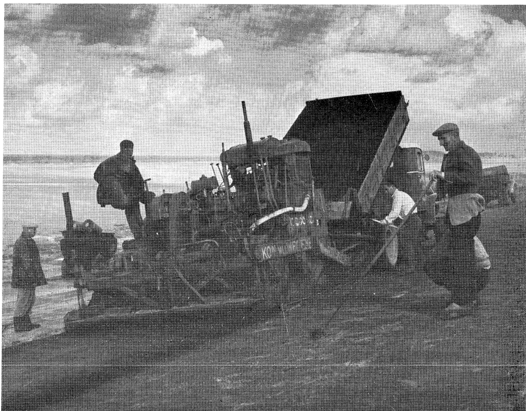
Het aanbrengen van de bovenlaag van asfaltbeton
