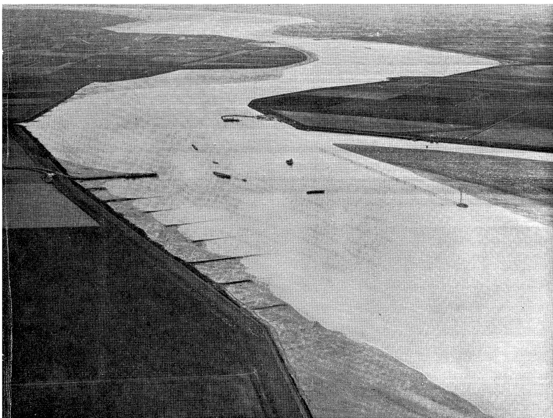
Het allereerste begin van de aanleg van een bouwput voor de sluis in de Zandkreek bij Katse Veer (20 mei 1957)
