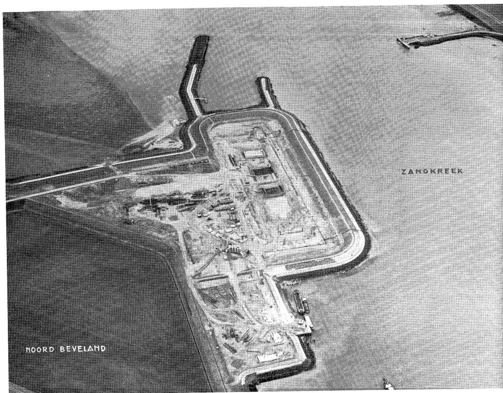
De sluisbouw in de Zandkreek op 29 december 1958
