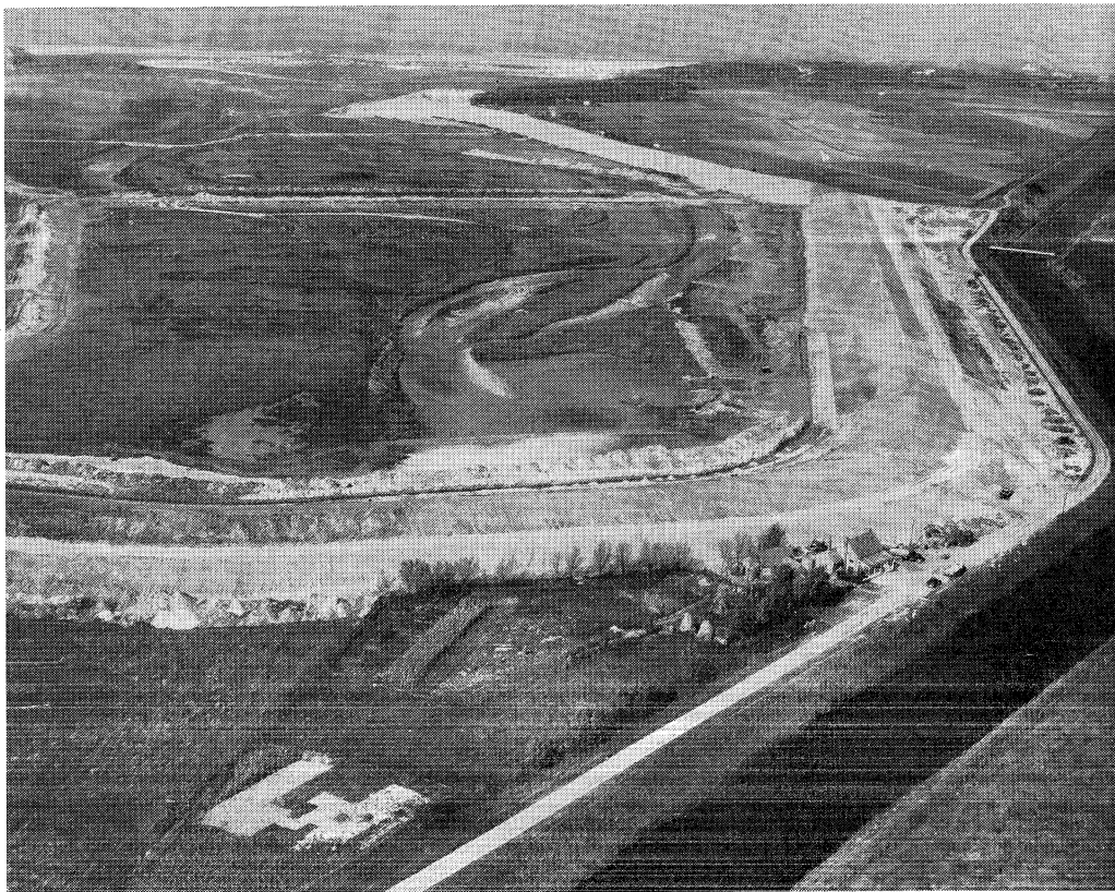
Het Nederlandse gedeelte van de waterkering rond het Zwin tijdens de uitvoering van de verbeteringswerken. Op de achtergrond de Noordzee met rechts de duinen van Cadzand
