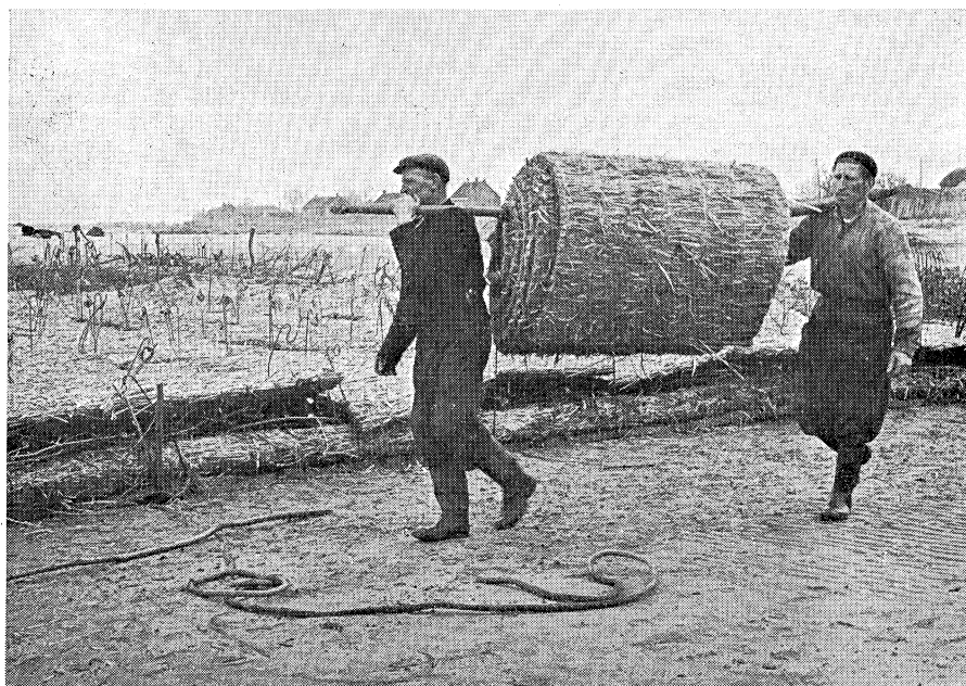
3. Aanvoer van de geperste rietmatten
