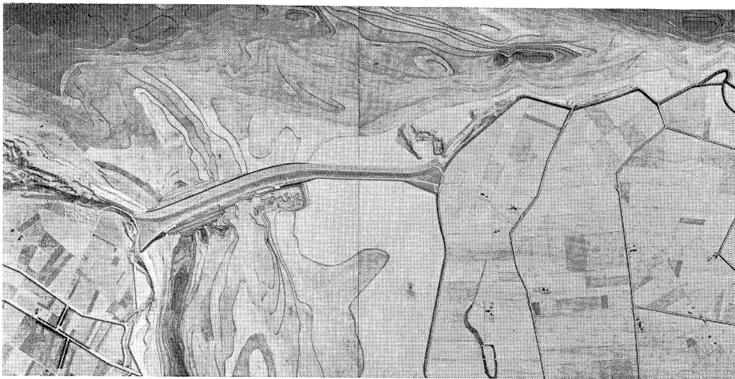
De voltooide dam
