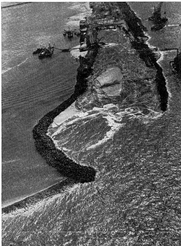
Ringdijk rond bouwput in het Haringvliet. Het 'bastion' van grof gr. 1 en stortsteen. Opname a.d. 16 juli 1957
