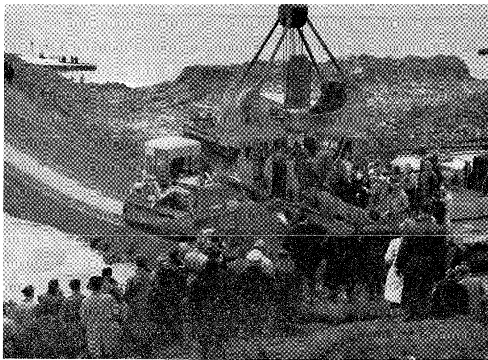
De sluiting van de ringdijk 12 november 1957
